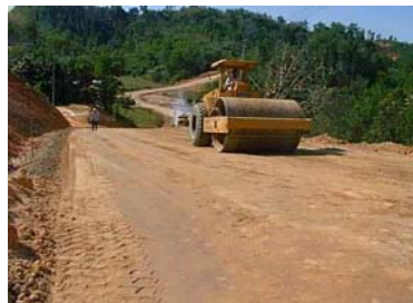
Compattazione del materiale
